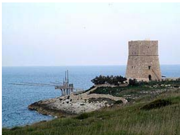
Torre di Porticello
